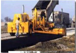
**Asfaltadora:** Posee una exactitud casi milimétrica posibilitando realizar peraltes y dar inclinación a las pendientes.
